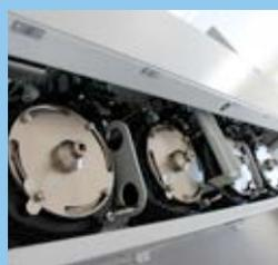
Les filtres MicroPur® se trouvent à l'étage supérieur du bâtiment. Pour le moment trois modules de filtration sont installés, deux modules comportant quatre carters et un module deux carters. La capacité de nettoyage atteint pour le moment 1 200 l/min. Un doublement de la capacité des filtres a été prévu dès la conception.
