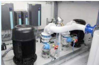
Entre autres, la redondance est de rigueur pour les pompes d'alimentation d'une puissance de 55 kW.
