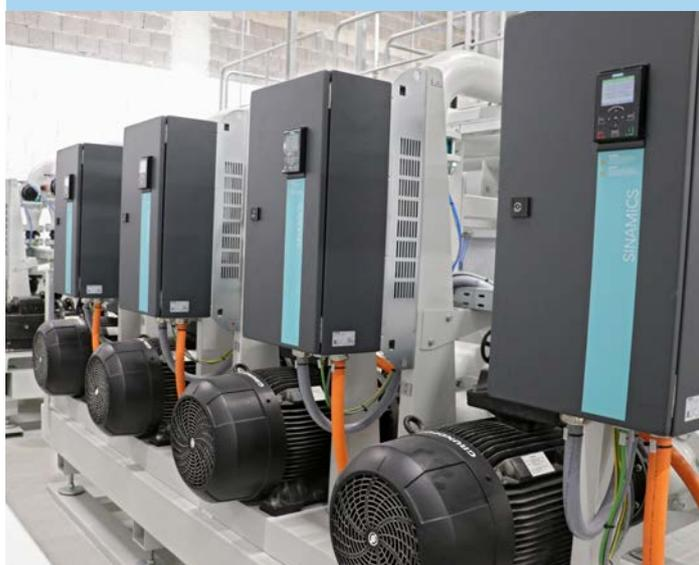
Au premier plan, on peut voir les cinq pompes de process KNOLL de l'installation pour solution aqueuse. Celles-ci refoulent le fluide épuré vers les machines en fonction des besoins. En arrière-plan se trouvent les trois pompes de filtration un peu plus petites qui sont toutes commandées par fréquence.
