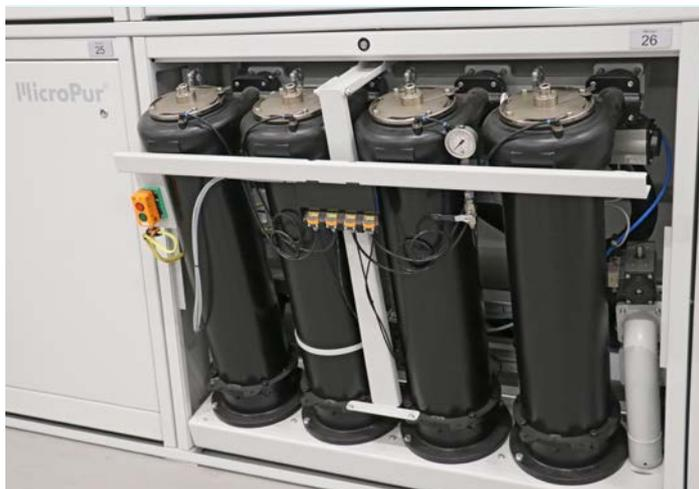
Les caissons modulaires MicroPur® sont équipés de quatre boîtiers de filtre contenant chacun deux cartouches filtrantes. La capacité de nettoyage par module est de 400 l/min.
