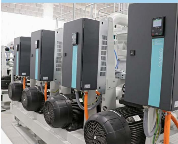
En primer plano pueden verse las cinco bombas de proceso KNOLL de la instalación para solución acuosa. Bombean el medio limpio de vuelta a las máquinas según sea necesario. Al fondo se ven las tres filtro-bombas algo más pequeñas, todas ellas controladas por frecuencia.
