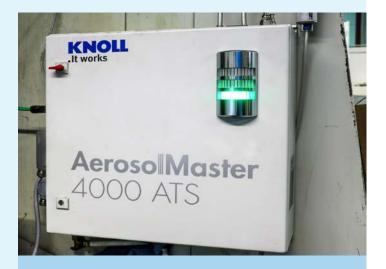
La particularidad de la lubricación seca por aerosol radica en la generación de un aerosol fino con un tamaño medio de gota de 0,25  $\mu m$ . Por lo tanto, el aerosol prácticamente no se disgrega, ni siquiera a altas temperaturas ni en largas distancias.
