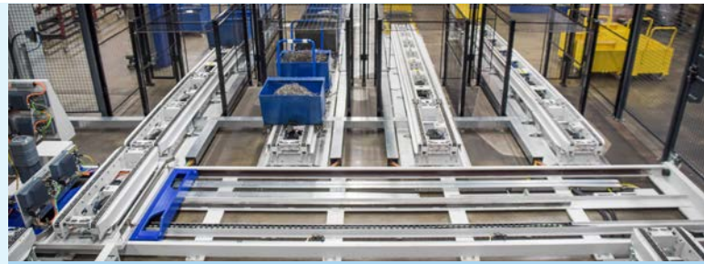
Am Ende der Pufferstrecken werden die Spänewagen über eine Querverfahrstrecke zu den Zentrifugen transportiert.
