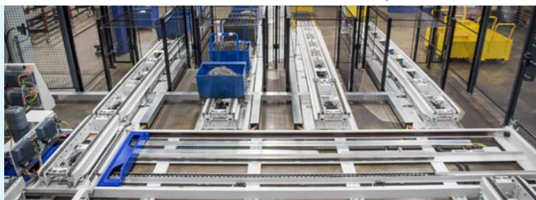
Am Ende der Pufferstrecken werden die Spänewagen über eine Querverfahrstrecke zu den Zentrifugen transportiert.
