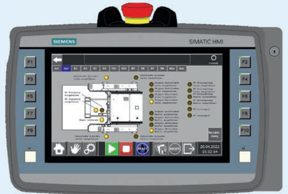
Vue d'ensemble des capteurs dans un détail de l'installation
