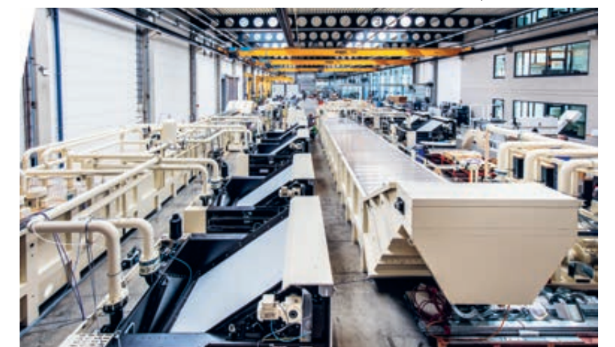
7 Montering av centralsystem
