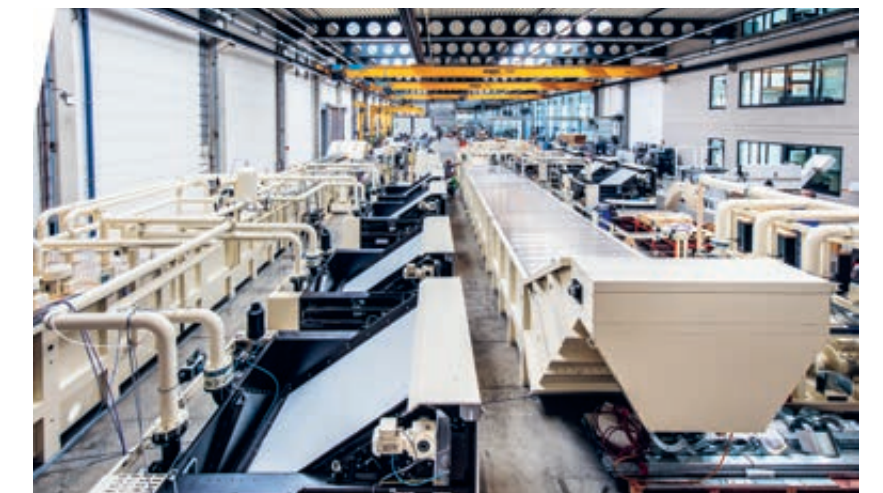
Montage centrale installaties 7
