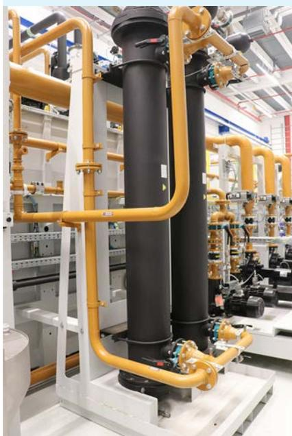
Deux échangeurs de chaleur de sécurité de 3 m de haut garantissent une température constante du lubrifiant réfrigérant et éliminent le risque de contamination de l'eau de forage utilisée pour le refroidissement.
