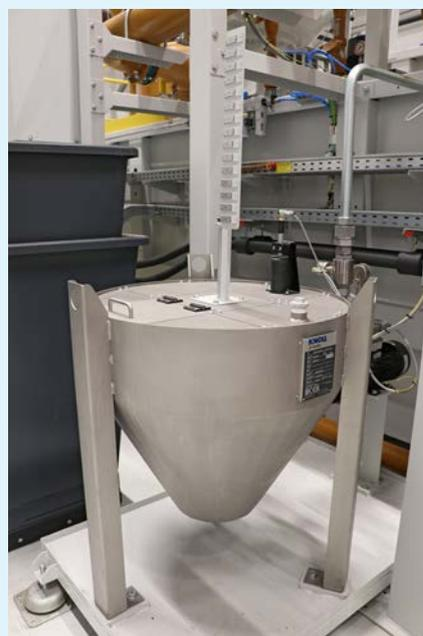
Ce dispositif de levage permet de doser automatiquement les additifs dans le lubrifiant réfrigérant.
