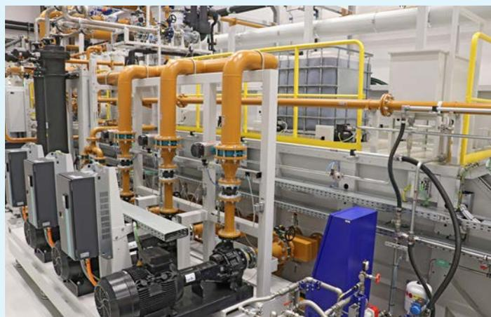
Au premier plan à gauche : trois pompes process à variation de fréquence dotées chacune d'une capacité de pompage de 2000 l/min. Elles assurent une alimentation des machines adaptée aux besoins et donc économe en énergie.
