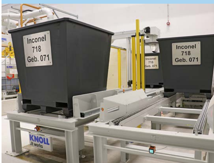
Am Ende des Schlammräumers werden die Inconel-Späne über eine Schwenkrutsche in die Spezialbehälter gefördert (im Hintergrund). Der für sieben Behälter ausgelegte Containerbahnhof erlaubt einen bedienerlosen Wochenendbetrieb.
