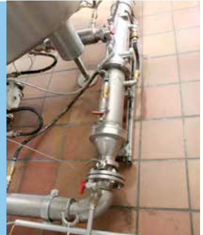
Die KNOLL Exzentrerschneckenpumpe MX30S hat auf Wunsch von Ritter Sport zur Beheizung einen doppelwandigen, verschweißten Mantel verpasst bekommen.
