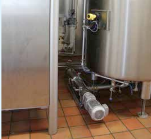
Zwischen Pufferbehälter und Temperiermaschine sitzt die KNOLL Exzentrerschneckenpumpe MX30S. Sie sorgt für einen gleichmäßigen Förderstrom und somit kontrollierte Kristallisation der Kakaobutter.
