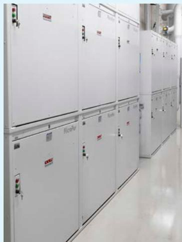
Nel primo stadio costruttivo sono stati installati quindici moduli del filtro standard MicroPur® 480 M. Ogni modulo contiene quattro casse, ciascuna dotata di due cartucce filtranti. Esse possono essere sostituite in uno a due minuti – semplicemente e senza gocciolare.
