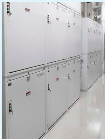
Dans la première phase d'installation, quinze modules du filtre standard MicroPur® 480 M ont été installés. Chaque module contient quatre boîtiers dotés de deux cartouches chacun. Celles-ci peuvent être remplacées en seulement une à deux minutes – en toute simplicité et sans aucune goutte.
