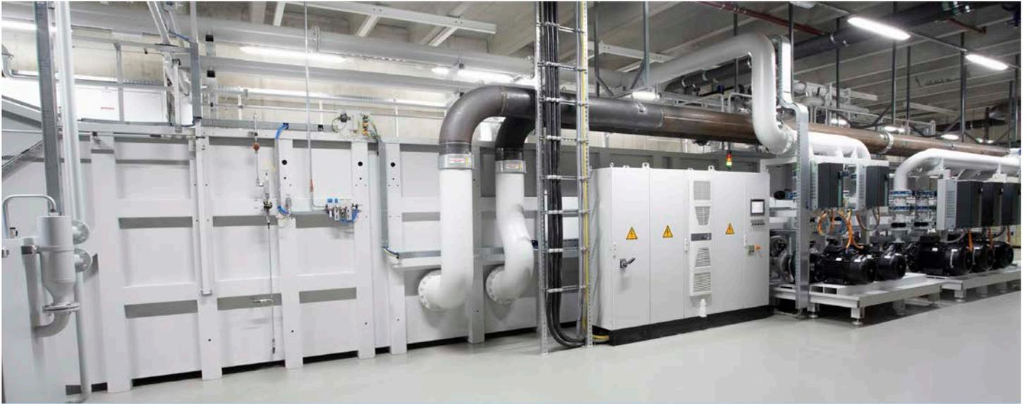
Convence por la alta calidad del aceite de rectificado, la temperatura constante y los costes moderados: la instalación central de KNOLL se basa en la tecnología de filtrado MicroPur®. En la primera fase de la ampliación se limpian hasta 6000 l de aceite de rectificado por minuto. En la fase final, la capacidad aumenta hasta 12 000 l/min.
