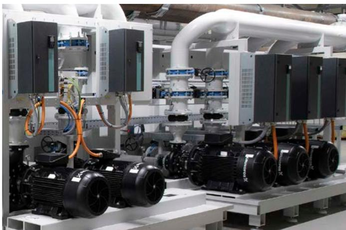
En la primera fase de ampliación de la instalación central de lubricante refrigerante de KNOLL ya se prepara la ampliación de las bombas de proceso y de filtrado para la fase final. Todas las bombas están equipadas con un convertidor de frecuencia, lo que garantiza un funcionamiento eficiente del sistema desde el punto de vista energético.
