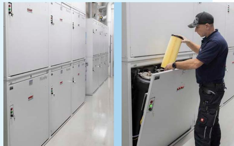
En la fase inicial de ampliación se instalan quince módulos del filtro estándar MicroPur® 480 M. Cada módulo contiene cuatro carcasas, con dos cartuchos cada una. Se pueden cambiar en tan solo uno o dos minutos, de forma sencilla y sin goteo.
