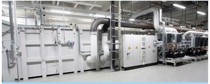
Überzeugt durch hohe Schleifölqualität, konstante Temperatur und moderate Kosten: Die KNOLL Zentralanlage basiert auf MicroPur®-Filtertechnik. In der ersten Ausbaustufe werden bis zu 6.000 l Schleiföl pro Minute gereinigt zur Verfügung gestellt. Im Endausbau sind es 12.000 l/min.
