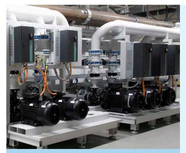
In der ersten Ausbaustufe der KNOLL KSS-Zentralanlage ist die Erweiterung der Prozess- und Filterpumpen für den Endausbau bereits vorbereitet. Jede Pumpe ist mit einem Frequenzumrichter ausgestattet; dies sorgt für einen energieeffizienten Anlagenbetrieb.
