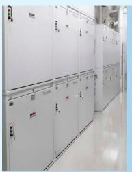
In der ersten Ausbaustufe wurden fünfzehn Module des Standardfilters MicroPur® 480 M installiert. Jedes Modul enthält vier Gehäuse, die jeweils mit zwei Patronen bestückt sind. Diese lassen sich in nur ein bis zwei Minuten wechseln – einfach und tropffrei.
