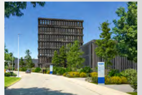
Completamento dei due nuovi edifici amministrativi K1 e K2.
